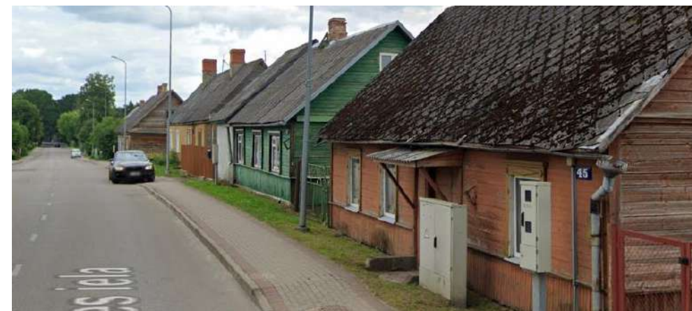
Pilskalnes ielas apbūve
