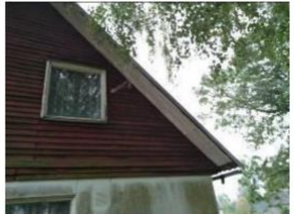
6.attēls. Fasādes fragments
