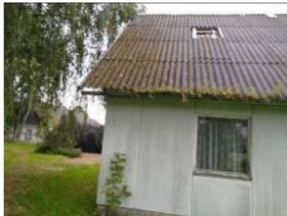
1., 2.attēls. Ēkas fasāde
