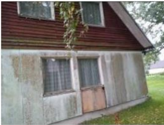
5.attēls. Fasādes fragments
