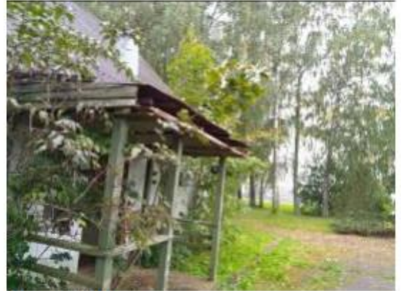
3.. 4.attēls. Ēkas fasāde
