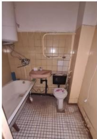
Savienotā sanitārtehniskā telpa
