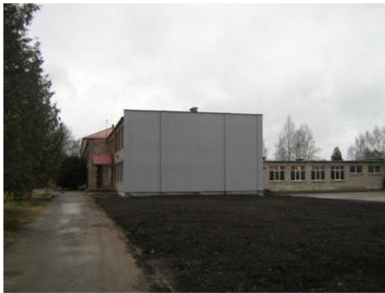
Sociālā pakalpojumu centra „Pīlādzis” nojauktā ēkas daļa
