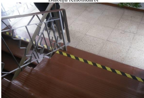
Kāpņu telpu remontdarbi
