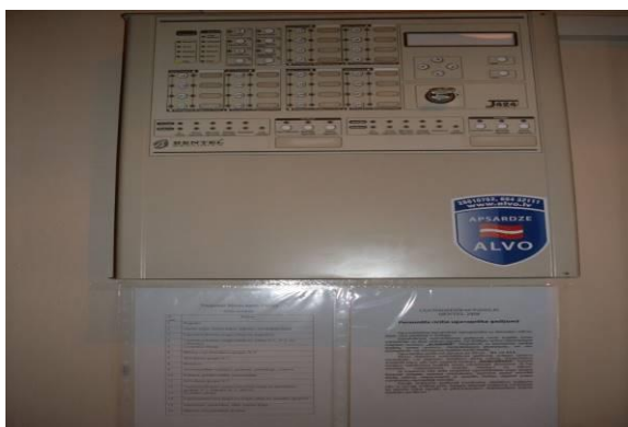
Ugunsdrošības signalizācijas iekārtas uzstādīšana
