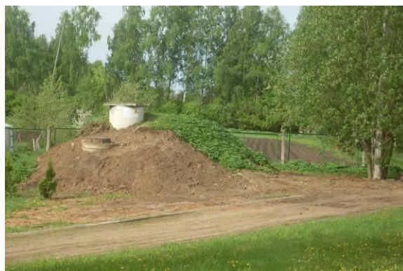
Degvielas padeves caurules remontdarbi
