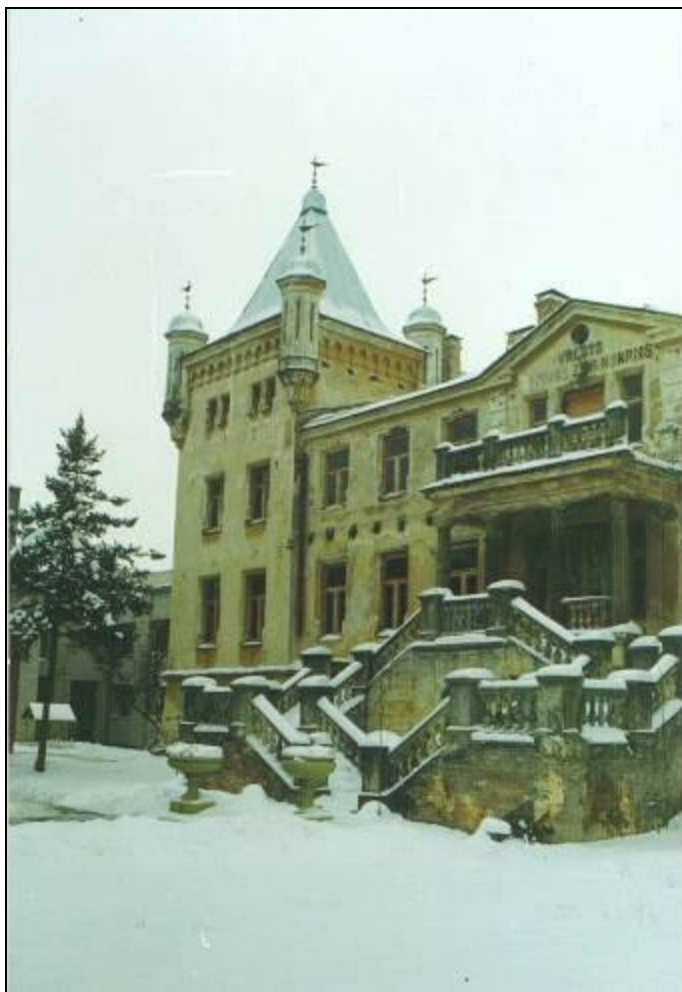
2.attēls. Kalkūnes muižas apbūve (Foto © Vanda Baulina)
