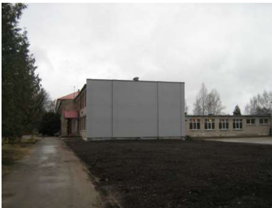
Sociālā pakalpojumu centra „Pīlādzis” nojauktā ēkas daļa
