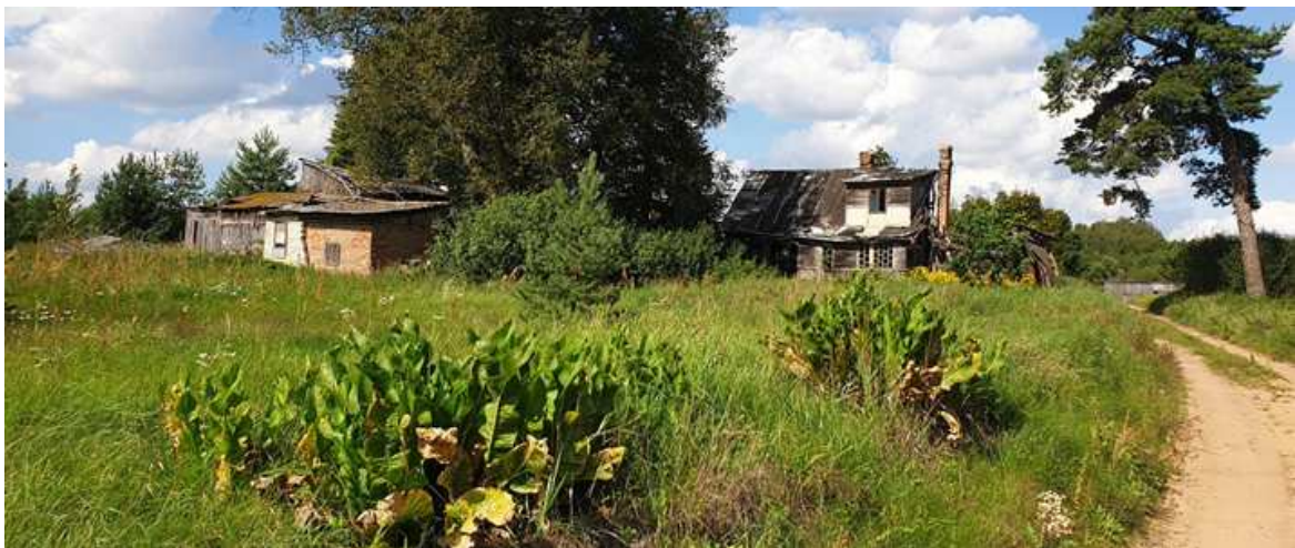
8.attēls. Daļa no apdzīvotās vietas "Meža Mackeviči" mājvietām ir pamestas un daļēji sabrukušas.
