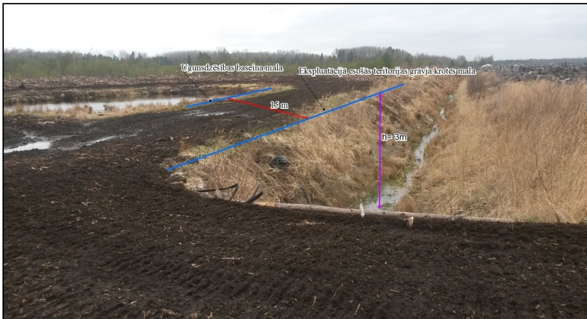
6.2.1. attēls. Novadgrāvja atbērtnē izveidots ūdens aizsprosts Nīcgales kūdras ieguves vietā ar kūdras blīvēšanas paņēmieni
